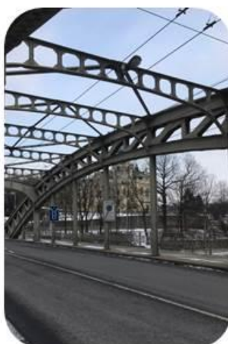
Obr. č. 4: Mostní konstrukce
